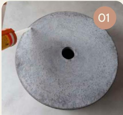
Aplicar una línea de silicona alrededor del perímetro inferior de la bacha, a 10mm del borde.
