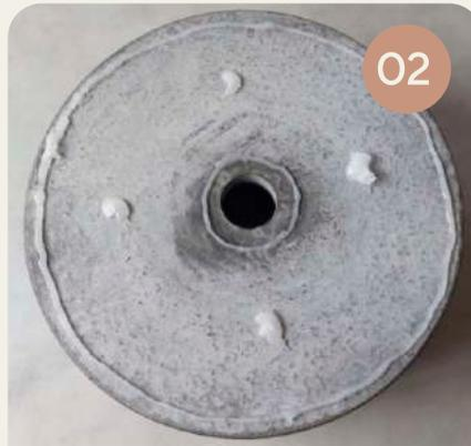
Aplicar una línea de silicona a 20mm del agujero del desagüe. Entre las dos líneas de silicona, aplicar 4 puntos más.
